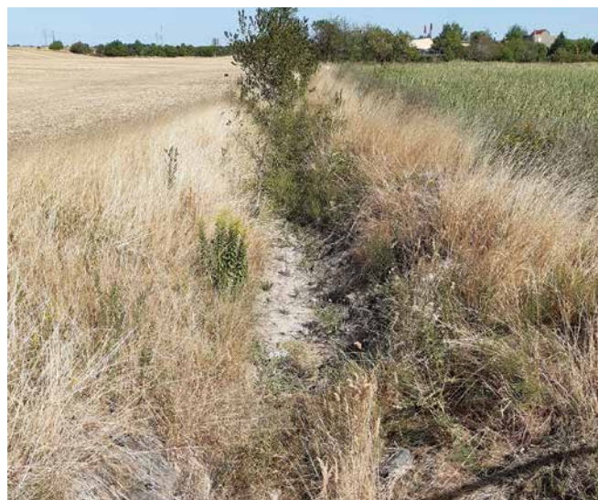
Foto 2 vom 11. August 2022: Thiemiggraben im Bereich Waldaer Straße Foto: Stadtverwaltung Großenhain/MP
